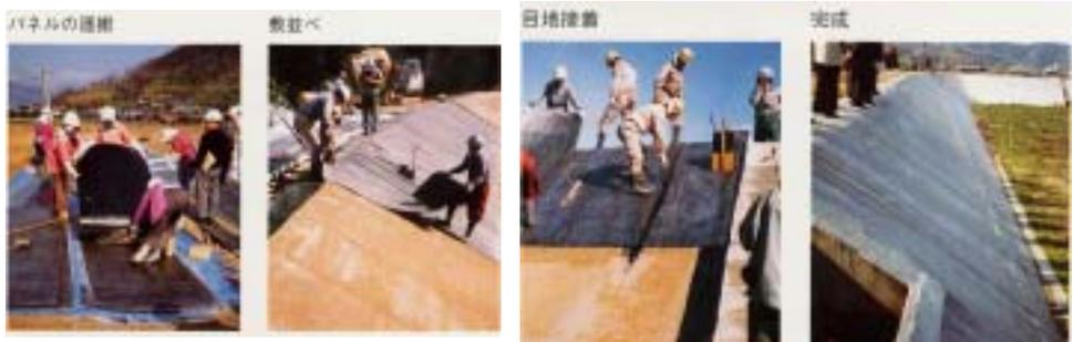
図-5 パネル工法施工手順の説明
